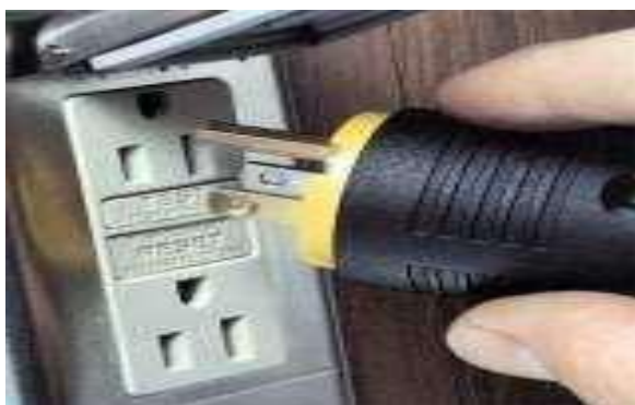
Gambar 2.7 Gambar peralatan yang mempunyai grounding yang benar
