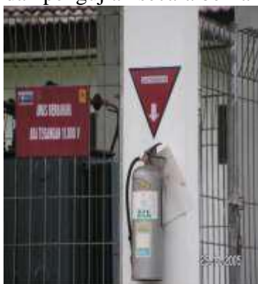
Gambar 2.9 Contoh APAR dan Penempatannya
