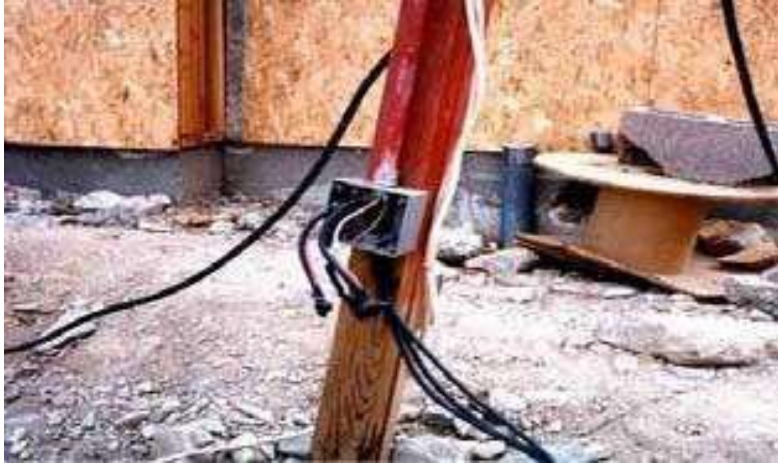
Gambar 2.2 Kondisi peralatan yang perlu diberikan penutup yang memadai
